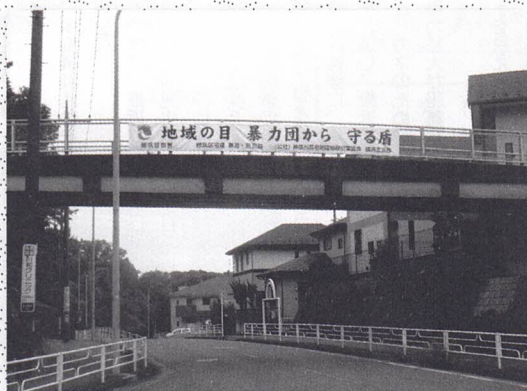
川和歩道橋 取付後
